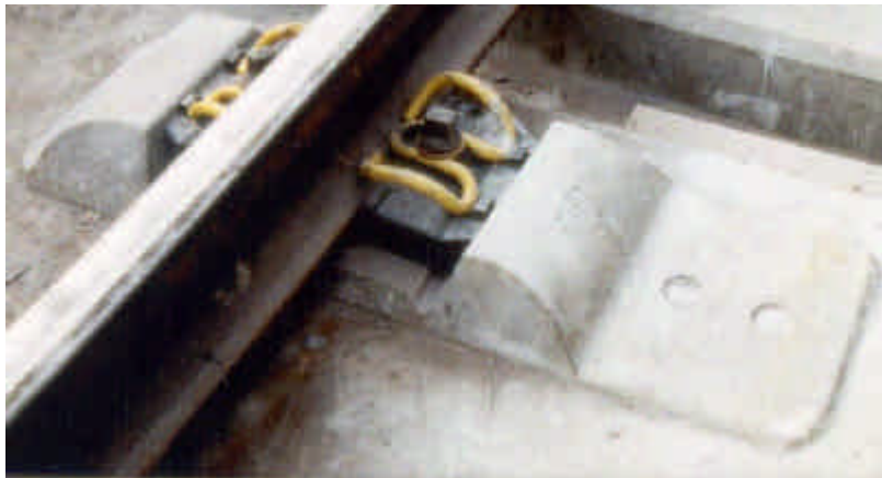
Figuur 3 Detail Rheda constructie
