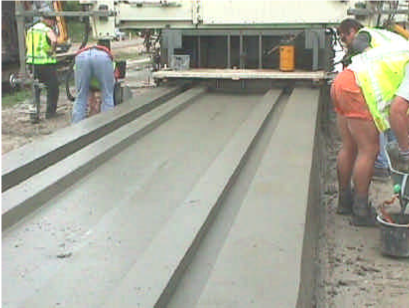
Figuur 9 Slipform paver
